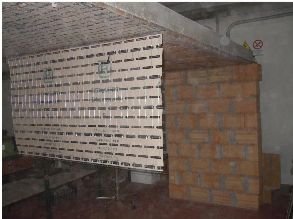
*Foto n. 4 – Applicazione della rete Stucanet® sull'intradosso della striscia di solaio*
