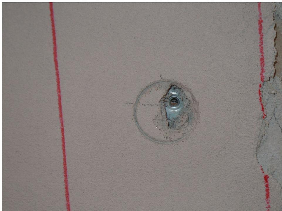
*Foto n. 14 – Rimozione del tassello di fissaggio della rete Stucanet® sul travetto*
