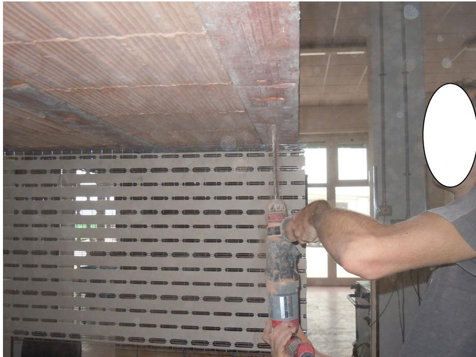
*Foto n. 3 – Preparazione dei perfori di alloggiamento dei tasselli per l'ancoraggio della rete*
