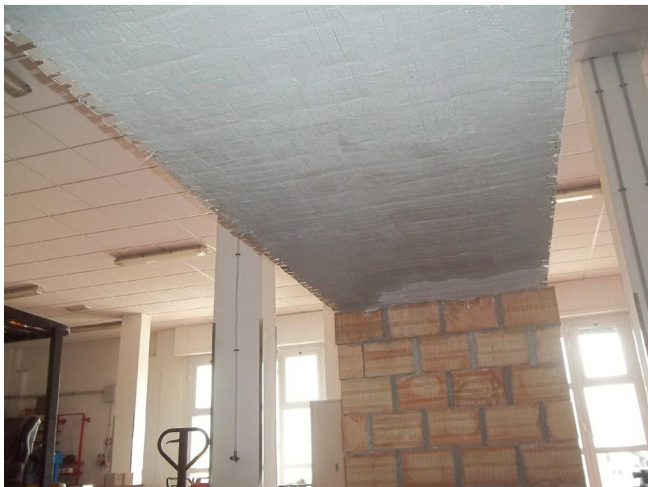
*Foto n. 7 – Applicazione completa dell'intonaco Plasterwall*
