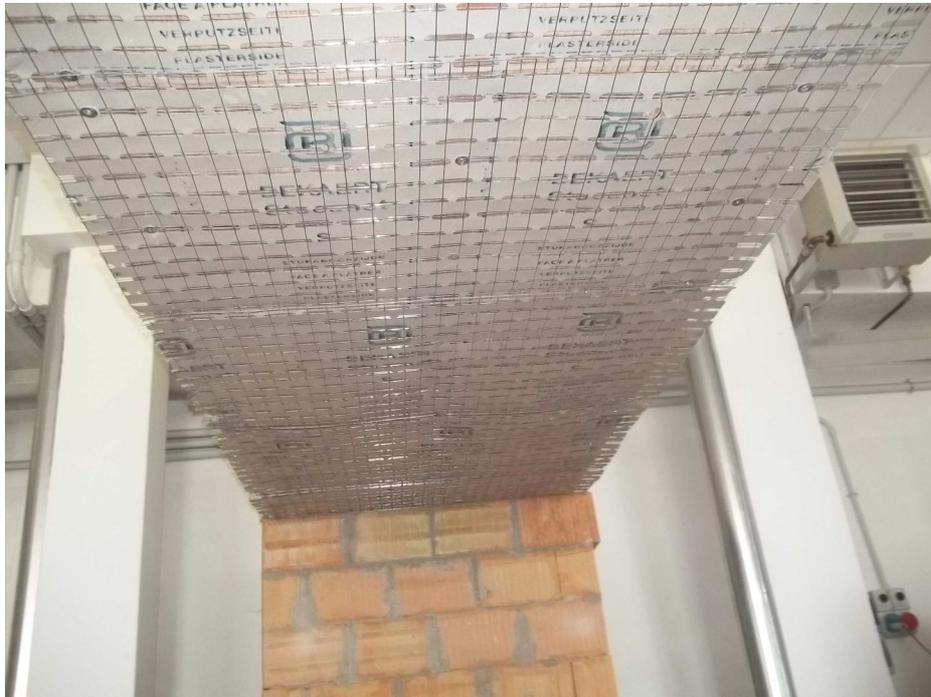
*Foto n. 5 – Posa in opera completa della rete Stucanet®*
