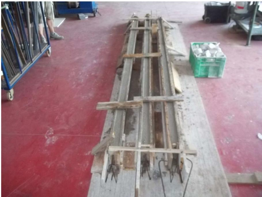
*Foto n. 1 – Fase costruttiva dei travetti del solaio*
