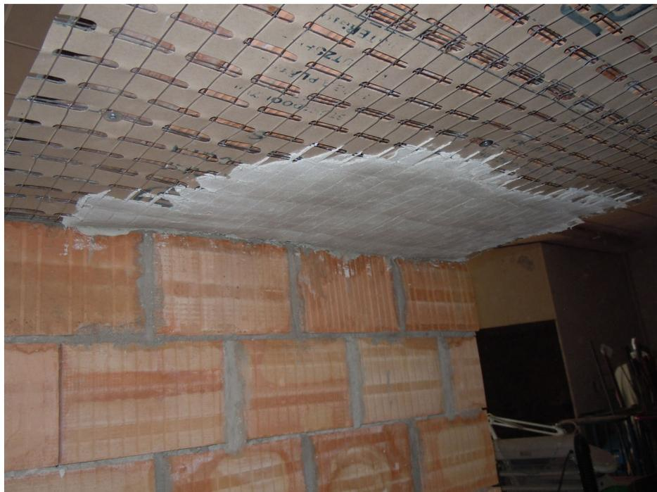
*Foto n. 6 – Applicazione dell'arriccio a base di malta Plasterwall*
