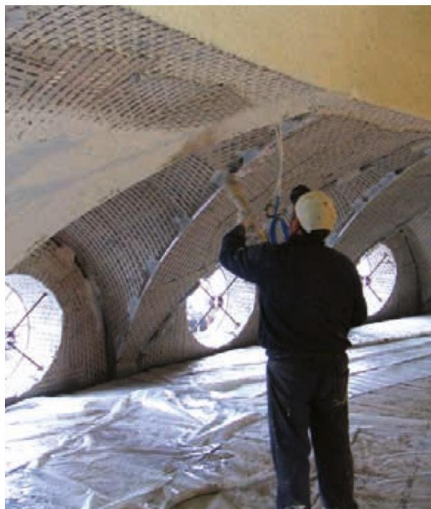
Nel caso del rifacimento della cupola del **teatro Petruzzelli** andata distrutta in seguito a un evento di incendio nel 1991, il sistema X Plaster è stato scelto dal progettista per la versatilità nel rivestimento di una superficie curva associata alle **elevate prestazioni in termini di Resistenza al Fuoco**.
