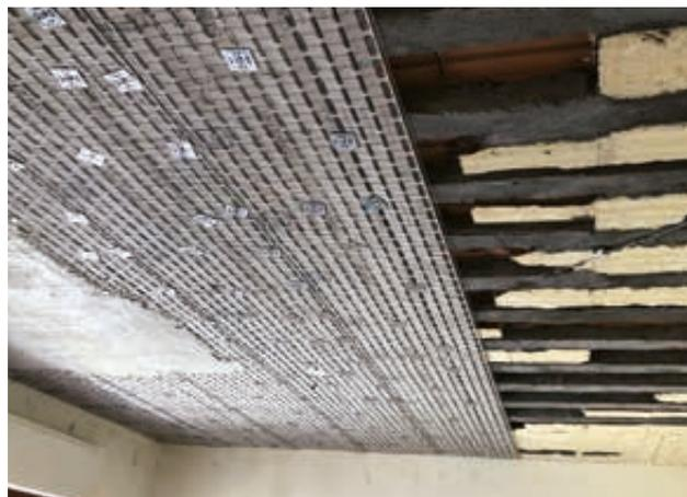
Applicazione del sistema antisfondellamento X Plaster.
