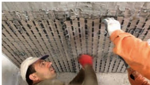
2) Posizionamento a soffitto del pannello Stucanet.
