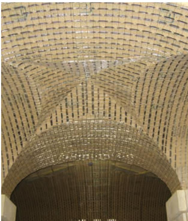
Con un adeguato sistema di appendamento è possibile realizzare volte e voltini complessi con finitura cementizia e una struttura di supporto flessibile **modellando i pannelli Stucanet secondo il disegno architettonico**.
