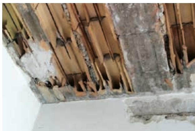
Sfondellamento causato da infiltrazioni che creano **dilatazione nei laterizi**, con precoce **invecchiamento dell'intradosso** del solaio abbinato all'**ossidazione corrosiva dei ferri d'armatura** dei travetti.
