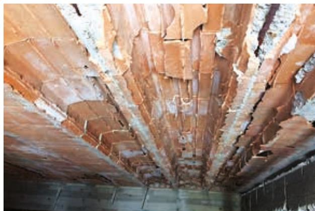
Pericolosità dello sfondellamento, generato dalla **rottura della cartella inferiore delle pignatte con distacco dal solaio e crollo** (anche per superfici estese e carichi di caduta importanti).
