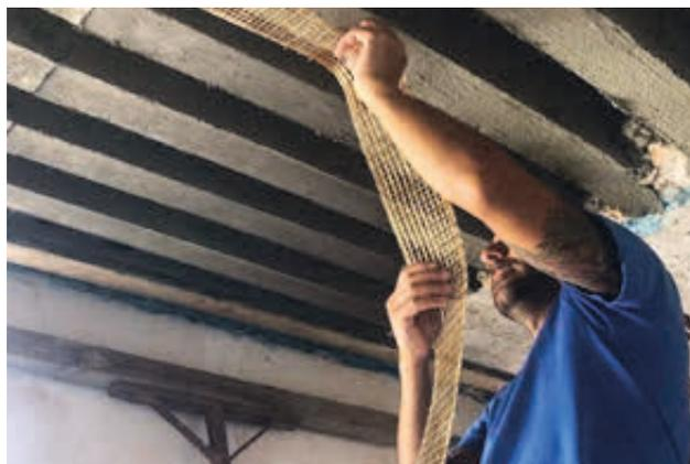
In caso di difetto di armatura si procede al rinforzo strutturale del travetto mediante tecnologia FRCM con **PBO-MESH 105** e matrice inorganica **MX-PBO Calcestruzzo**.
